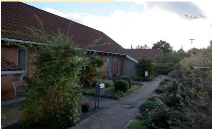
De private andelsboliger ved Sneslev Sognevej.
